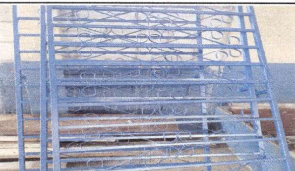
Foto 3: frabricación e instalación de ventana-balcon de metal
