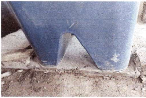
Foto 7: Sustrución de pila plástica de dos lavaderos
