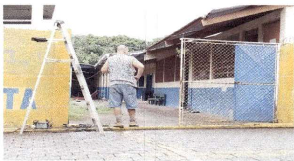
Foto 1: sustitución de porton de metal
